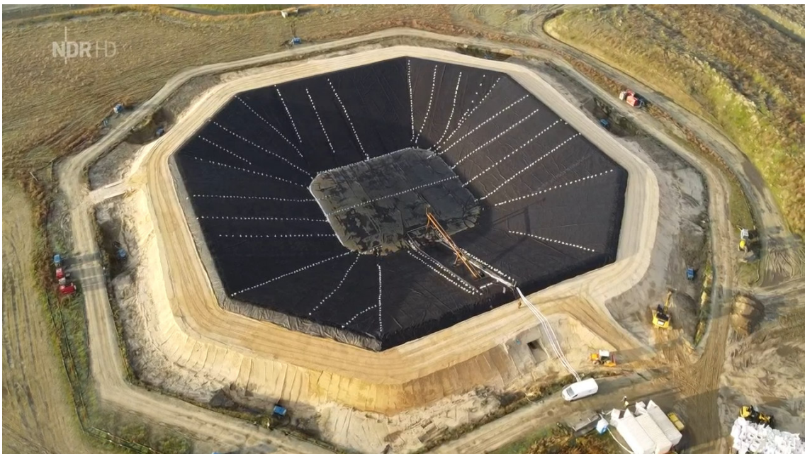
Abb. 51: Bau Erdbeckenwärmespeicher Meldorf mit rd. 43.000 m 3 (Quelle: www.ramboll.com )
