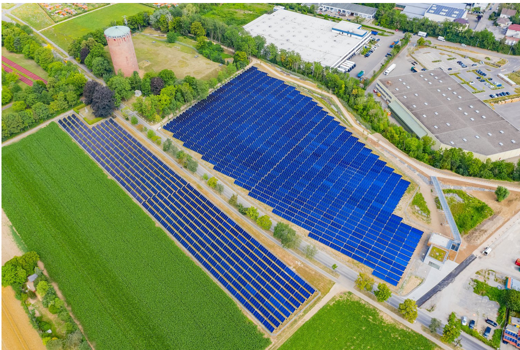
Abb. 1: Solarthermieanlage auf Ludwigsburger und Kornwestheimer Gemarkung (Quelle: SWLB)
