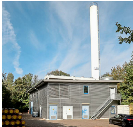
Die Heizzentrale in Pattonville.
