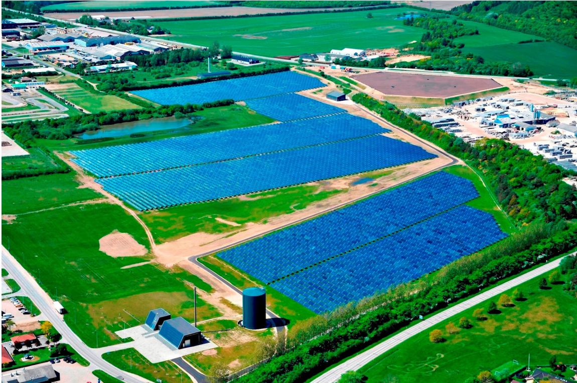
Abb. 50: Solarthermieanlage mit rd. 200.000 m 3 Erdbeckenwärmespeicher (Wärmespeicher oben rechts im Bild/ Quelle: www.vojensfjernvarme.dk )
