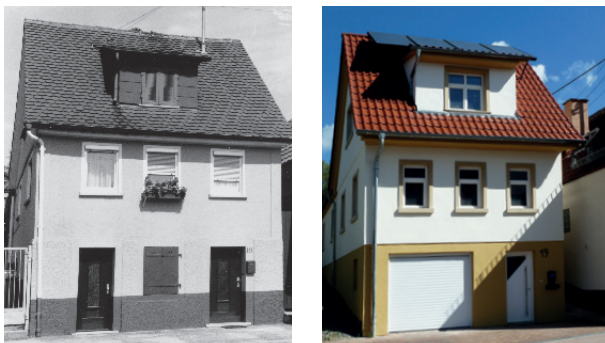
Das Objekt in der Küferstraße 19 vor und nach der Modernisierung.
