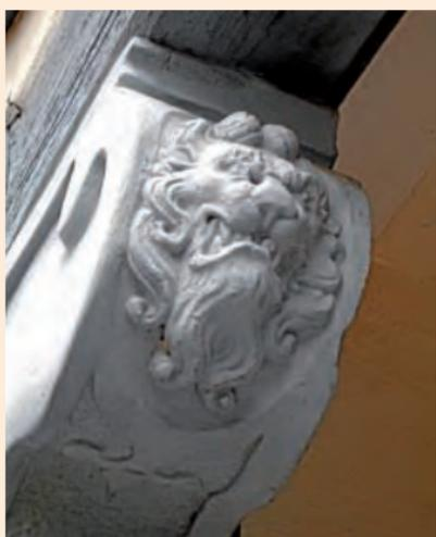
*An der Baufuge nimmt ein Konsolstein, der als Löwenkopf ausgebildet ist, das Gebälk des neu angefügten Gebäudetrakts auf*
